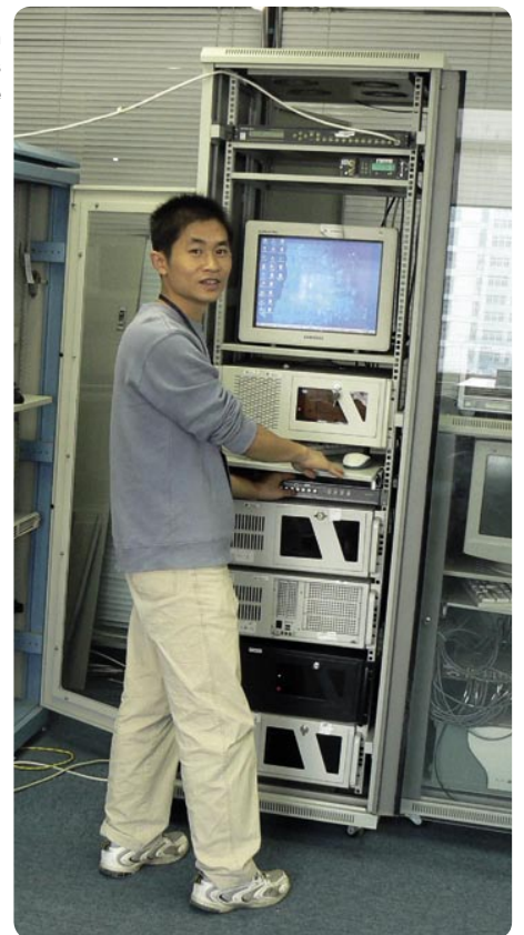
Verificando las capacidades funcionales de los módulos
