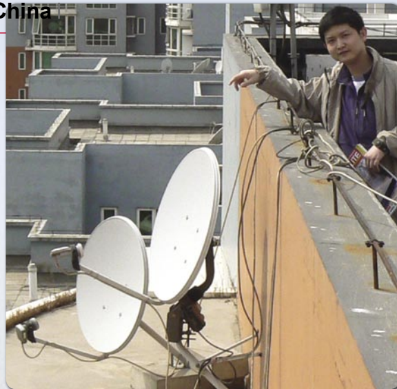
■ Unas antenas adicionales que están montadas en una baranda lateral: un plato de 75cm que apunta a 134° E con una antena motorizada de 60cm con un motor de MOTECK.
